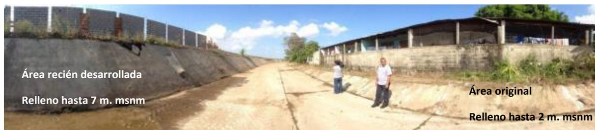
Foto 2-4 Ejemplo de un relleno actual y un relleno original
