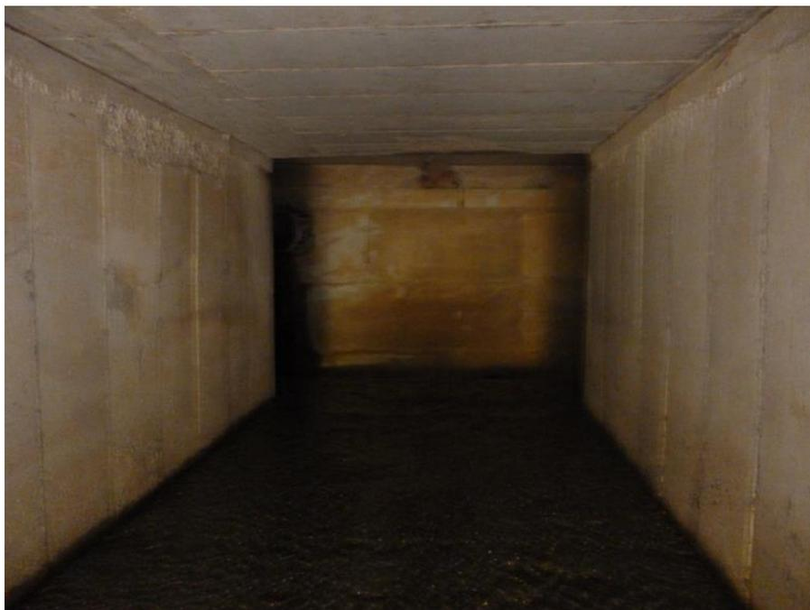
**Fotografía 8. Cambio de sección hidráulica de cajón simple de 3.05x2.75 metros a cuatro tuberías de 1.20 metros de diámetro. Se registra cambio de fondo de aproximadamente 1.0 metro de profundidad.**
