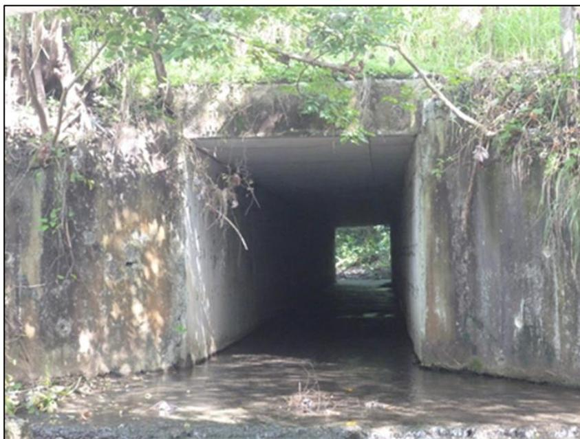
Pasando la servidumbre del Corredor Norte, se encuentra otro cajón con dimensiones similares, el cual conduce las aguas por debajo de la Avenida Condado del Rey y entra en los terrenos del centro comercial Country Plaza II, en ese punto la sección se reduce de un cajón simple, a cuatro tuberías de 1.20 metros de diámetro. Como se muestran en las figuras a continuación.
