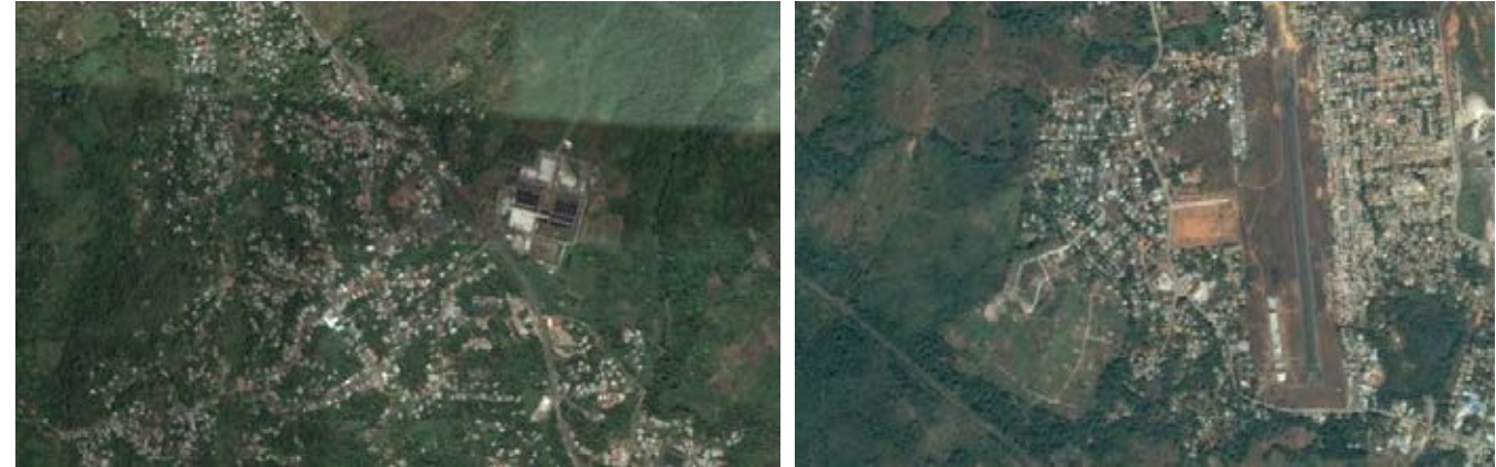
Imagen 188. Infraestructuras en el medio rural en el Distrito de Panamá. Potabilizadora de Chilibre (izquierda) y Aeropuerto Calzada Larga (derecha)
