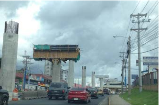
Imagen 91. Cableado y obras de metro en Avenida Domingo Díaz (Juan Díaz)
