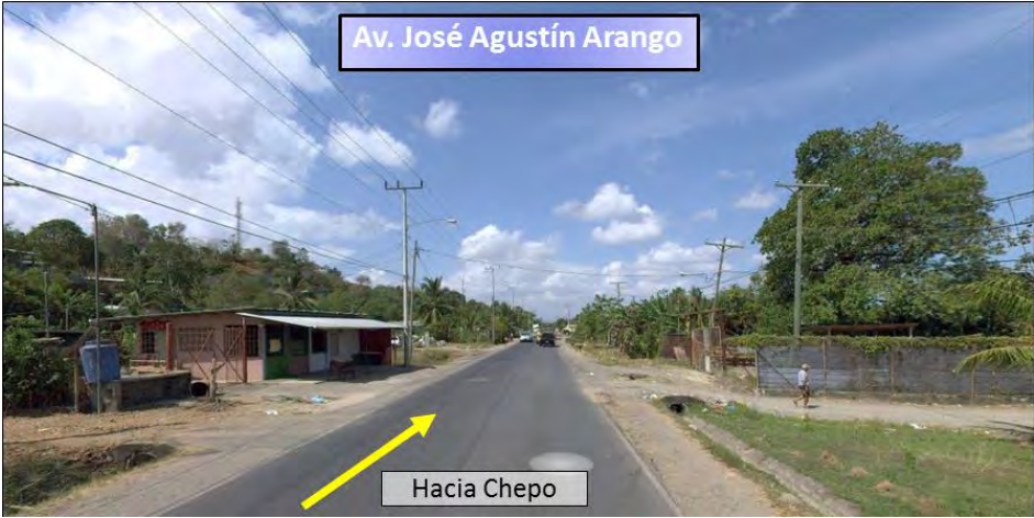
Imagen 115. Condiciones del drenaje de la zona homogénea 10.
