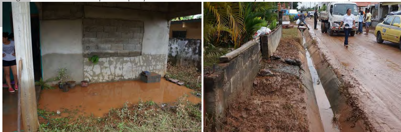
Imagen 151. Inundaciones por colapso y deficiencia de la red de drenaje pluvial en Ciudad Radial, Juan Díaz
