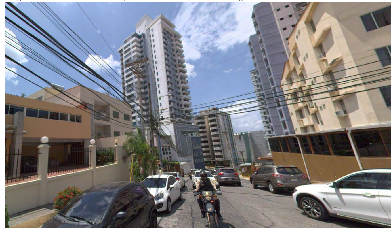
Imagen 125. Contaminación visual por líneas de distribución de energía eléctrica en el área de Villa de la Fuente.
