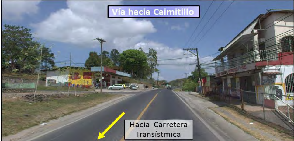
Imagen 114. Condiciones del drenaje de la zona homogénea 09.
