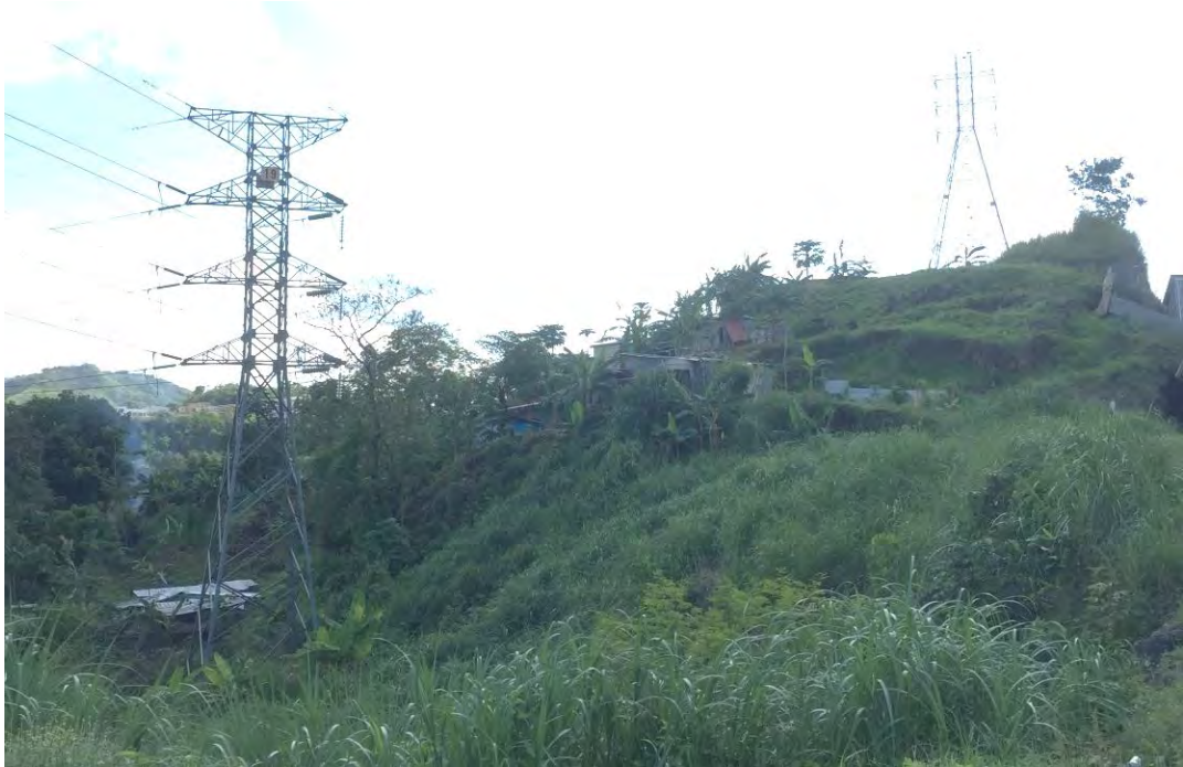
Imagen 124. Asentamientos informales en la servidumbre eléctrica. Condado del Rey.
