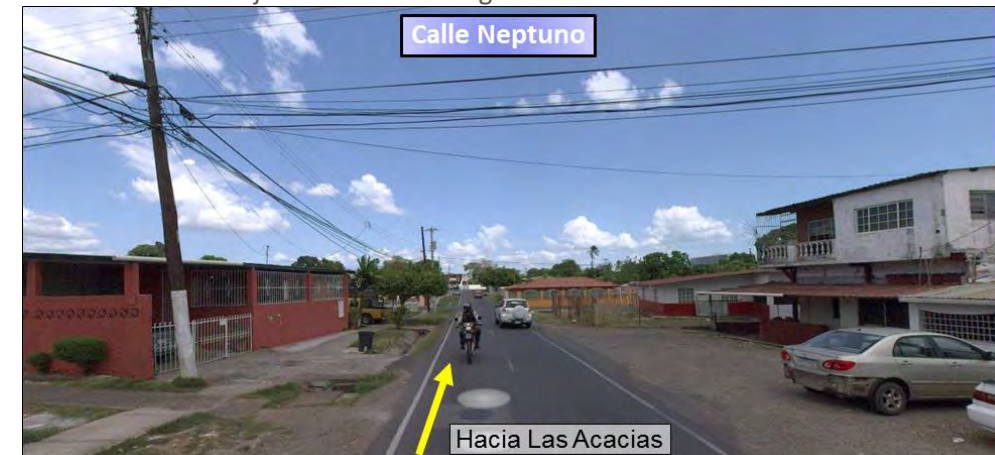
Imagen 110. Condiciones del drenaje de la zona homogénea 04.
