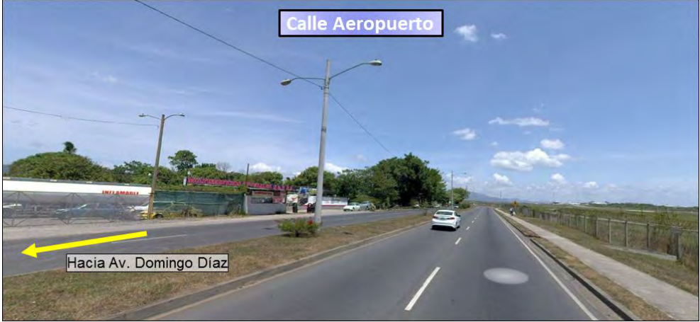
Imagen 113. Condiciones del drenaje de la zona homogénea 07 y 08.
