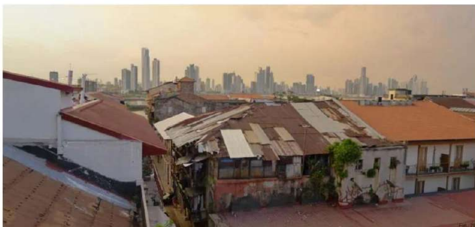
Fig. 79, Vista desde el Casco Antiguo a las torres en la Av. Balboa
